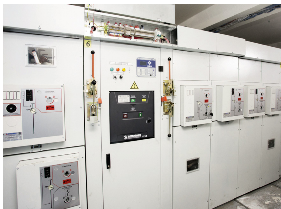
Распределительное устройство на базе ячеек КСО «Уссури»
